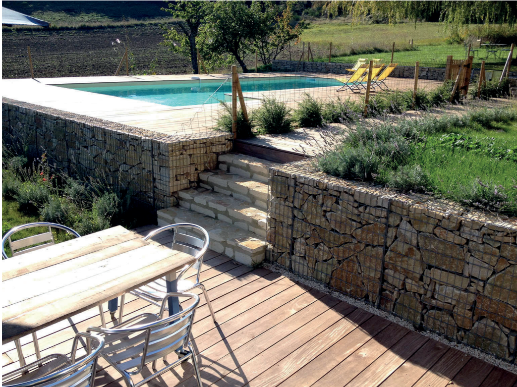
En soutènement, pour que le mur en gabion soit capable de retenir le talus, il est utilisé comme "mur poids". C'est donc son poids qui va s'opposer à la poussée du terrain à l'arrière, comme dans le cas de cette réalisation avec les produits Tendance Gabion.
