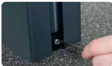
Mise en place du coulisseau d'appui
